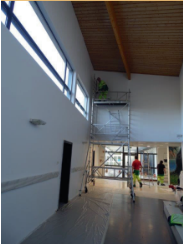
Pendant les congés de février, le service technique a rénové le couloir de l'école maternelle
