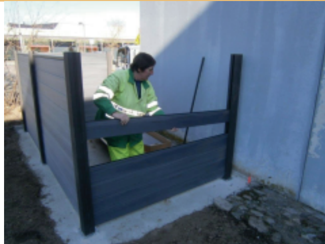
Un local dédié au rangement des poubelles à l'entrée du complexe sportif
